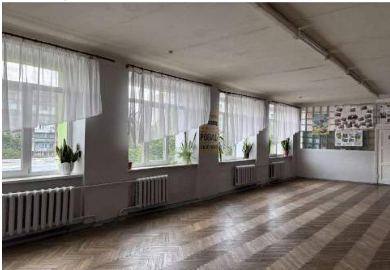
Ремонт 4-го поверху
