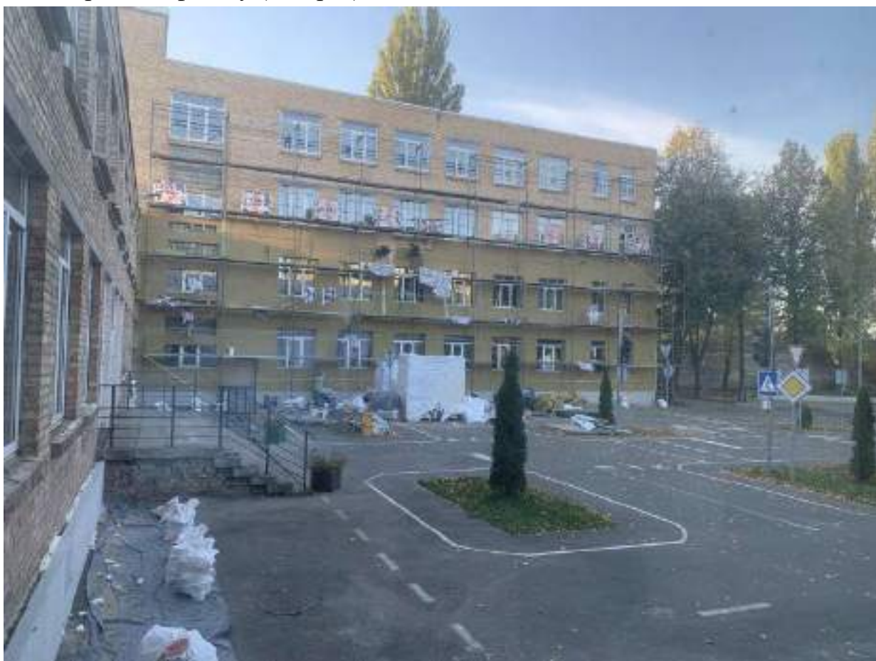
Капітальний ремонт фасаду (II черга)
