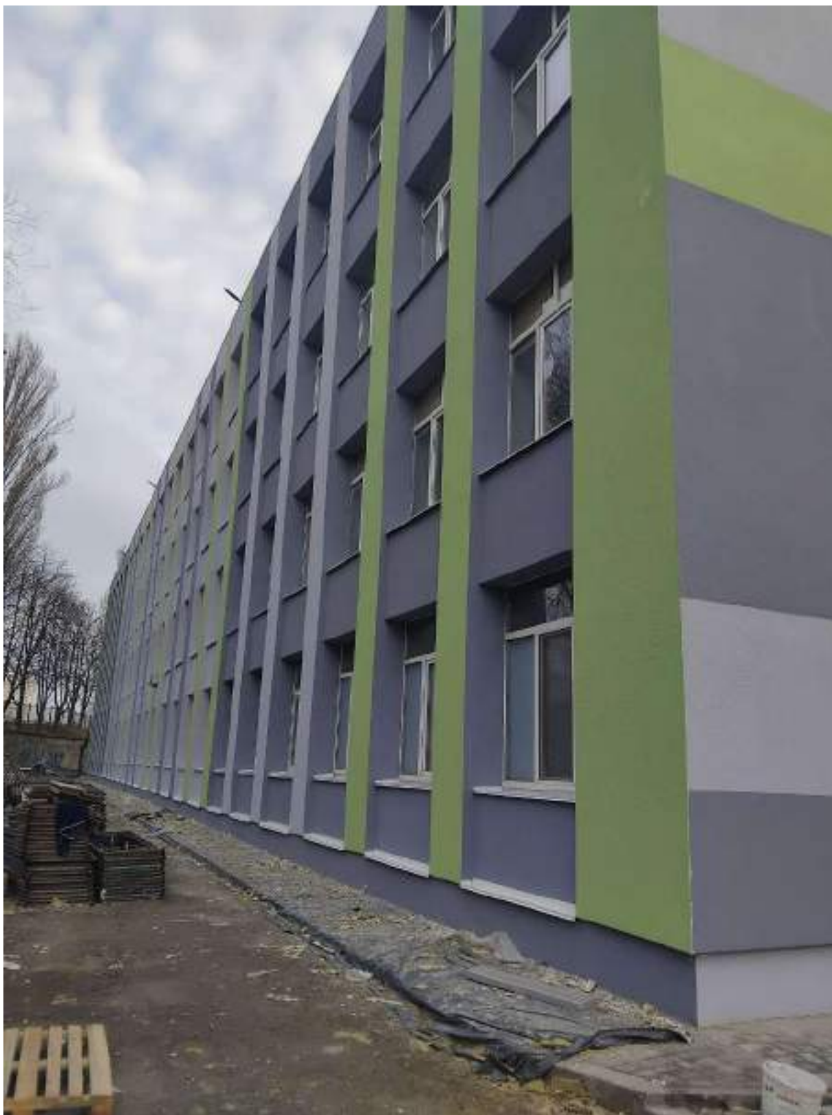
Капітальний ремонт фасаду (II черга)
